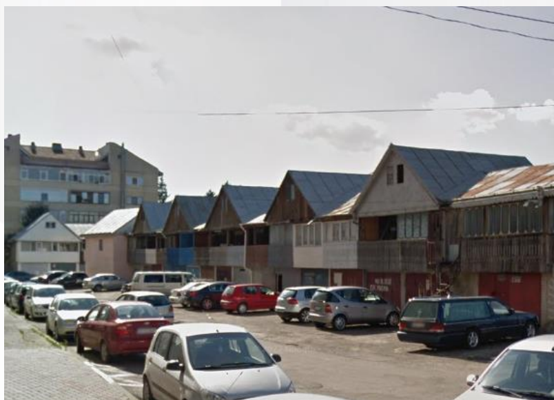
Figura 128 - Zonă garaje Strada Garabet Ibrăileanu – Strada Zimbrului, Pașcani
